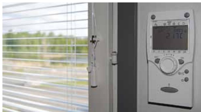
Система E-Flex расположенная за пределами здания. Система управляется из помещения беспроводным контроллером.
